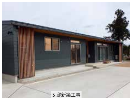
S 邸新築工事
